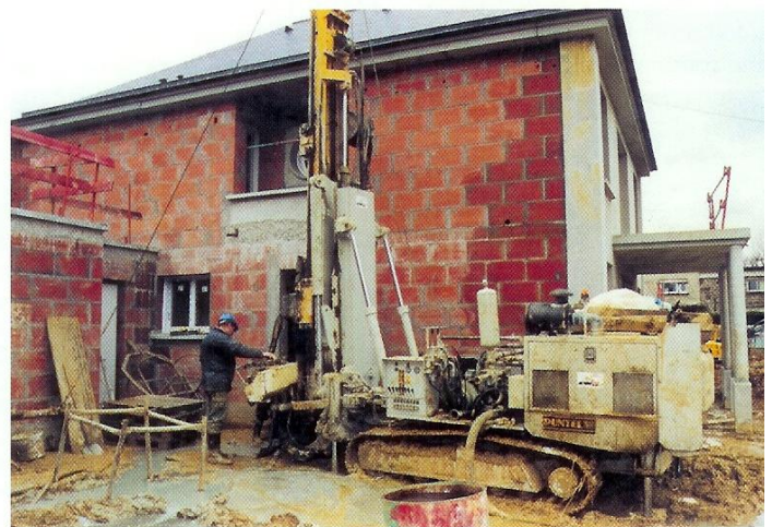
Les forages des capteurs enterrés (2 par générateur) ont été réalisés durant le premier semestre 2001, par une entreprise spécialisée.
